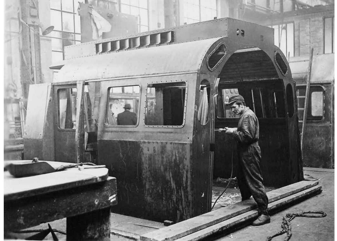
▲ Készül a legkorszerűbb magyar gőzmozdony védháza (fotó: Süveges Kálmán hagyatékából)
